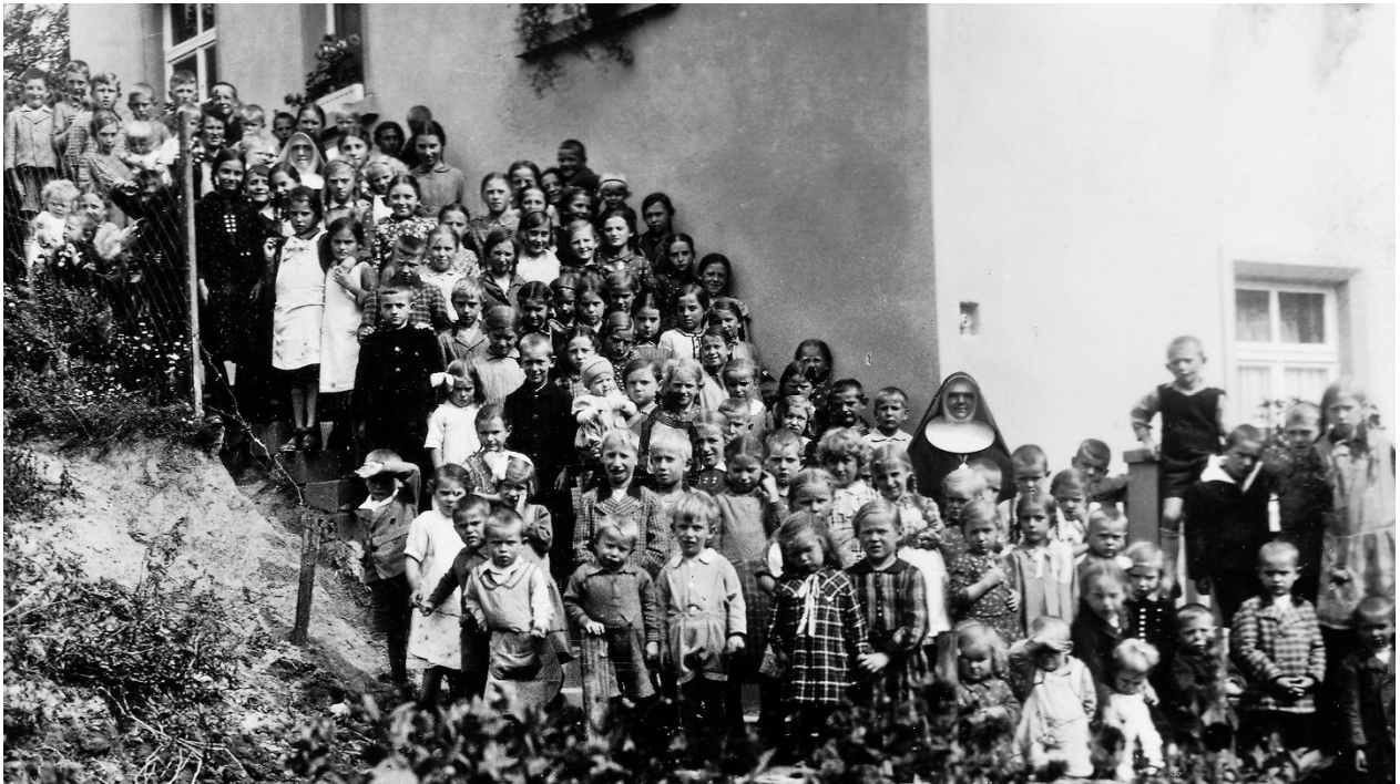
Über 100 Kinder (offensichtlich sind auch Schulkinder dabei) vor dem neuen Kindergarten in Vasbühl, nach 1934. 92
