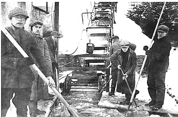
Mit Hilfe eines Rollaufzuges („Elevator“) wurden die zerkleinerten Schollen in den Kühlkeller transportiert. Noch zu Beginn der 1960er Jahre wurde so das Bier gekühlt und wer ein Fass kaufte, erhielt noch eine Stange Eis dazu.
