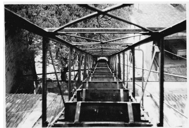
Mit Hilfe eines Rollaufzuges („Elevator“) wurden die zerkleinerten Schollen in den Kühlkeller transportiert. Noch zu Beginn der 1960er Jahre wurde so das Bier gekühlt und wer ein Fass kaufte, erhielt noch eine Stange Eis dazu.
